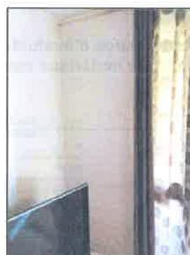
Photo N° 1845 AMIANTE CIMENT -Rdc-161-Séjour Mur intérieur Plaques planes (Fibres-ciment)
