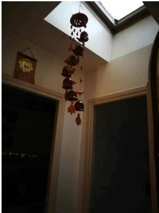
D'une pièce à vivre : plafond et mur peint, carrelage au sol – un châssis vitré double battants
