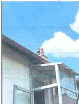
Photo N° 3124 AMIANTE CIMENT -Rdc-Jardin Conduits de fluide + chapeau Ventilation haute (Fibres-ciment)
