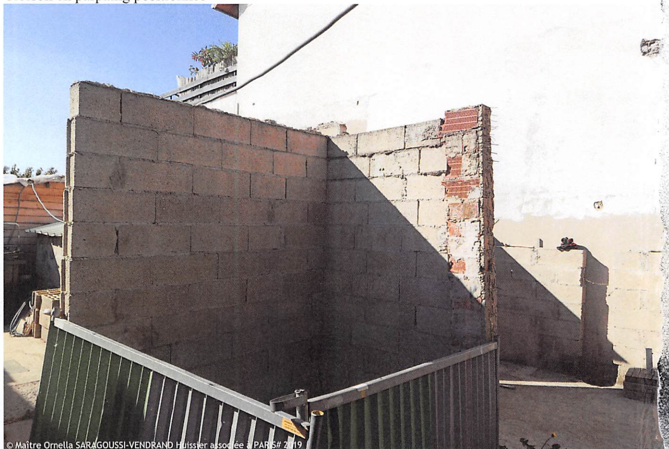
Cloison en parpaing positionnée
