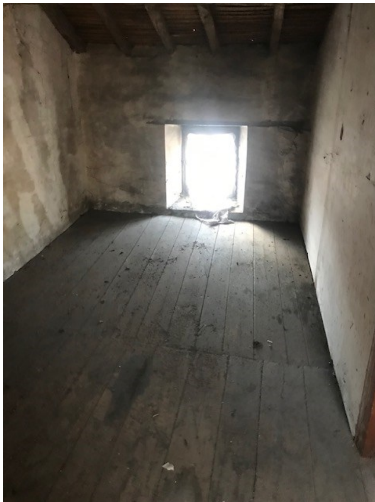
Plancher ancien en bois, peut-être une ancienne chambre de bonne. Deux petites fenêtres côté rue Lattage bois sans isolation.
