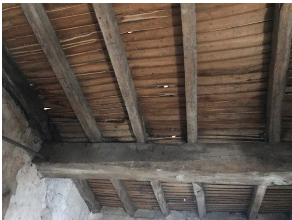
Plancher ancien en bois, peut-être une ancienne chambre de bonne. Deux petites fenêtres côté rue Lattage bois sans isolation.
