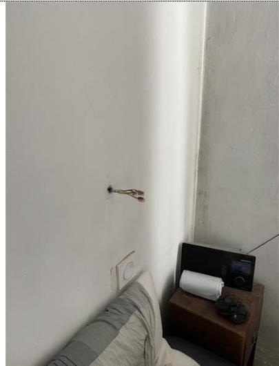
Description : L'installation électrique comporte au moins une CONNEXION avec une partie active nue sous tension accessible.
