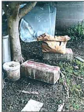
Photo N° 7948 AMIANTE CIMENT -Rdc-Jardin Planchers Bac à fleurs (Fibres-ciment)
