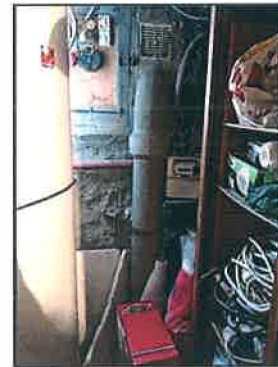
Photo N° 7949 AMIANTE CIMENT -Rdc-Chaufferie Conduits de fluide Ventilation basse (Fibres-ciment)
