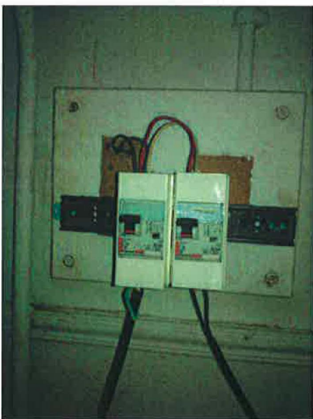
RDC : Chaufferie conducteurs non protégés.
