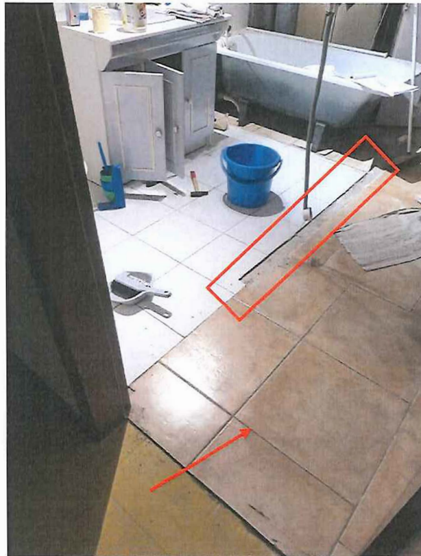
Accès à la pièce principale ; dalle béton apparente
