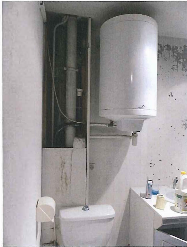
Conduite d'évacuation des WC apparente
