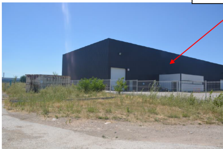
Bâtiment ARCELOR MITAL, édifié en partie sur les parcelles ZA 462 et ZA 464
