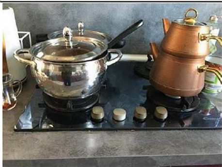
Photo n° PhGaz002 Localisation : Cuisine Table de cuisson CANDY (Type : Non raccordé)
