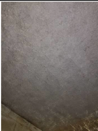
Photo n° PhA001 Localisation : Sous-sol - Parking Ouvrage : 4 - Plafonds et faux plafonds - Plafonds Partie d'ouvrage : Flocage Description : Flocage
