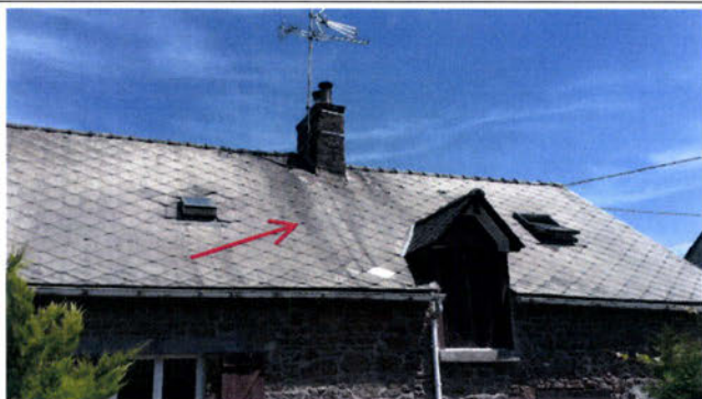
001 : Ardoises fibro-ciment Toiture
