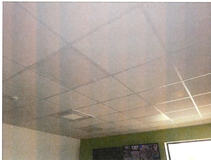
Au plafond, des dalles minérales posées sur armature métallique, accueillant une cassette de climatisation.
