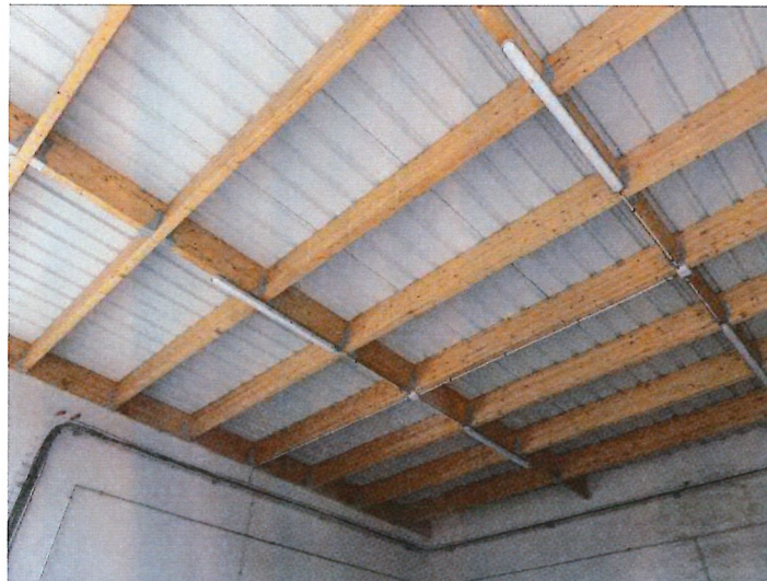
Au plafond, du bardage métallique posé sur structure en bois.
