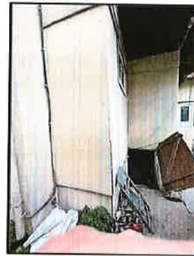
Photo N° 2 AMIANTE CIMENT -Rdc-Exterieur Murs Habillage des murs extérieur en plaques planes (Fibres-ciment)
