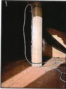
Photo N° 1 AMIANTE CIMENT -1er-Chambre 2 Conduits de fluide Ventilation haute (Fibres-ciment)
