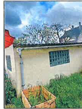
Photo N° 2 AMIANTE CIMENT -Rdc-Garage Toiture Toiture ondulée (Fibres-ciment)
