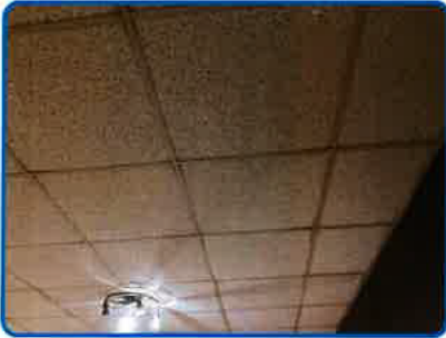
PRLV n° 1 sur Faux plafond Plaques polystyrènes
