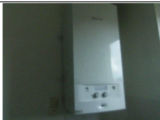
Photo n° Ph001 Localisation : Cuisine Chaudière e.l.m. leblanc (Type : Raccordé)
