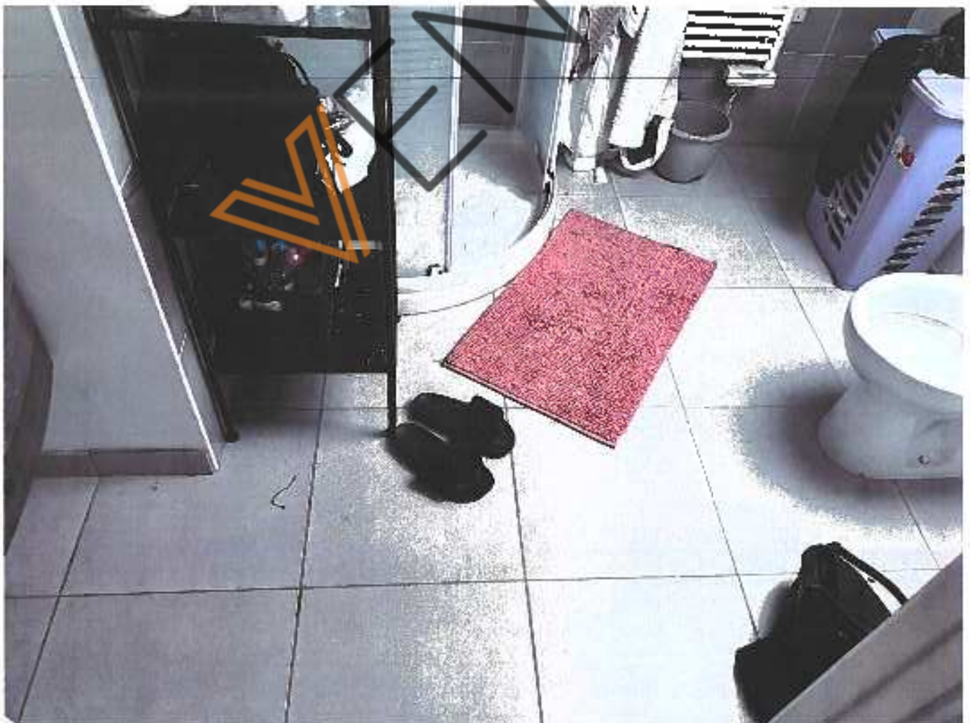
BKCPv description 46 rue des Ecluses 9160 LONGJumeau 22.12.2021 photo 134
