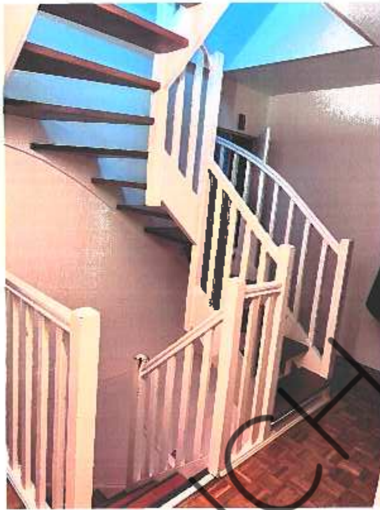
BIC Pr description 45 rue des Bleuets 91600 LONGJUMEAU 22.12.2021 photo 071
