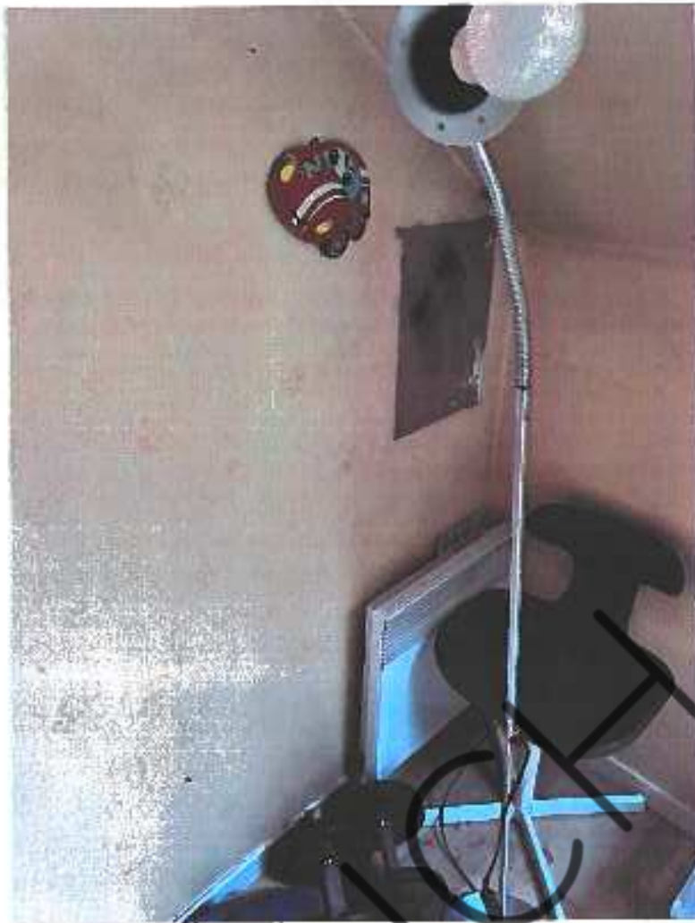
BUC Pu description 46 rue des Bleuets 9160 LONGJumeau 22.12.2021 photo 079
