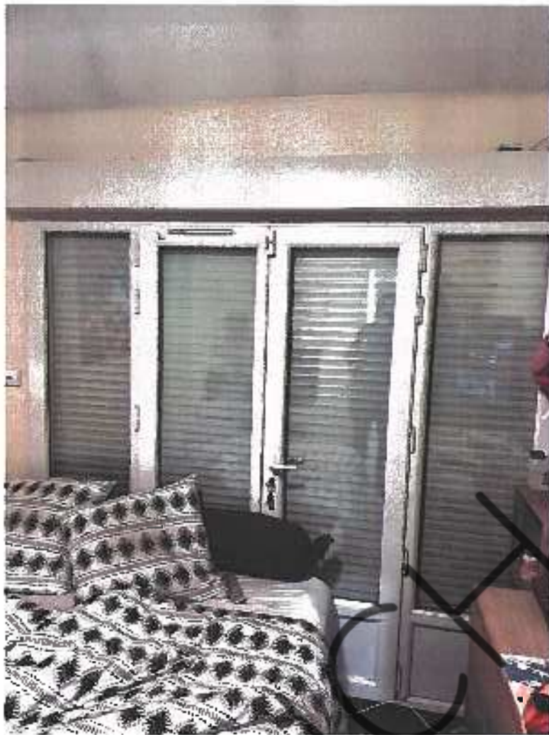
BIC Pv description 46 rue des Bleuets 9160 LONGJumeau 22.12.2021 photo 087
