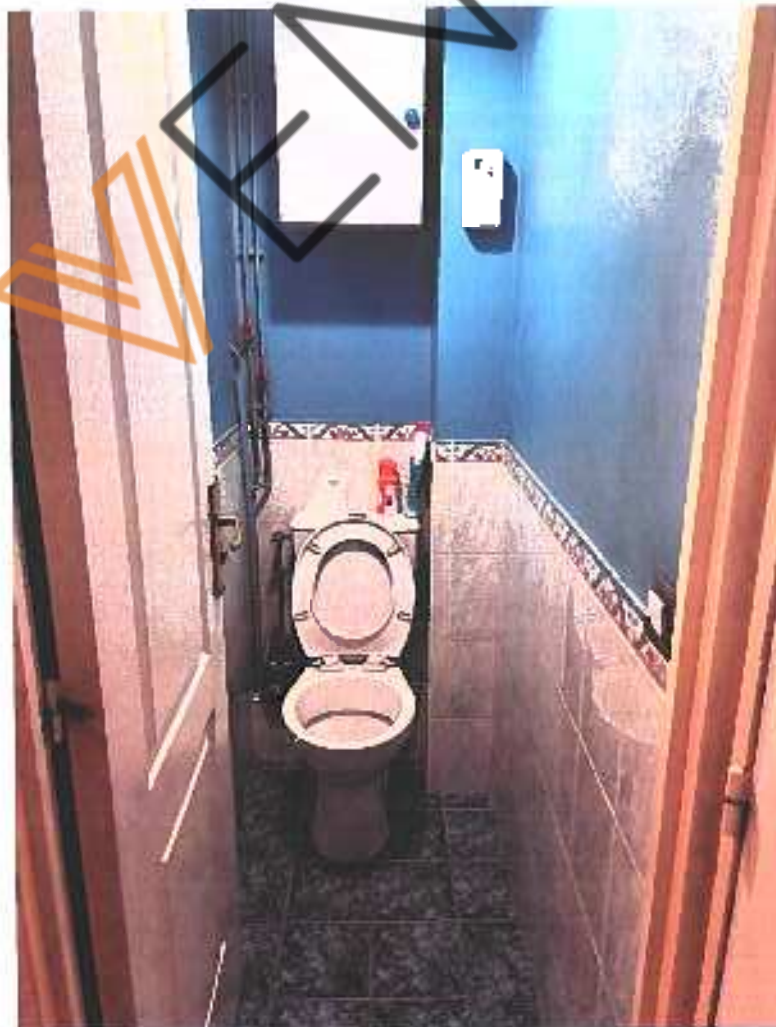
BUC Pu description 46 rue des Bleuets 9160 LONGJumeau 22.12.2021 photo 080
