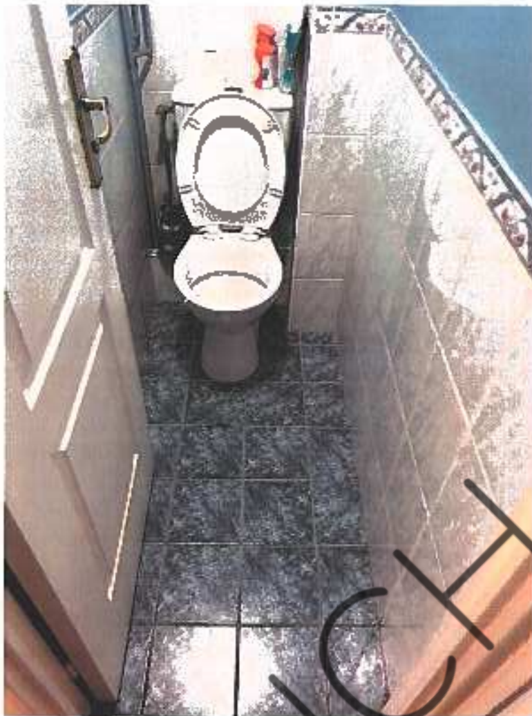
BIC Pr description 45 rue des Bouteils 91501 LONGJumeau 22.12.2021 photo 081
