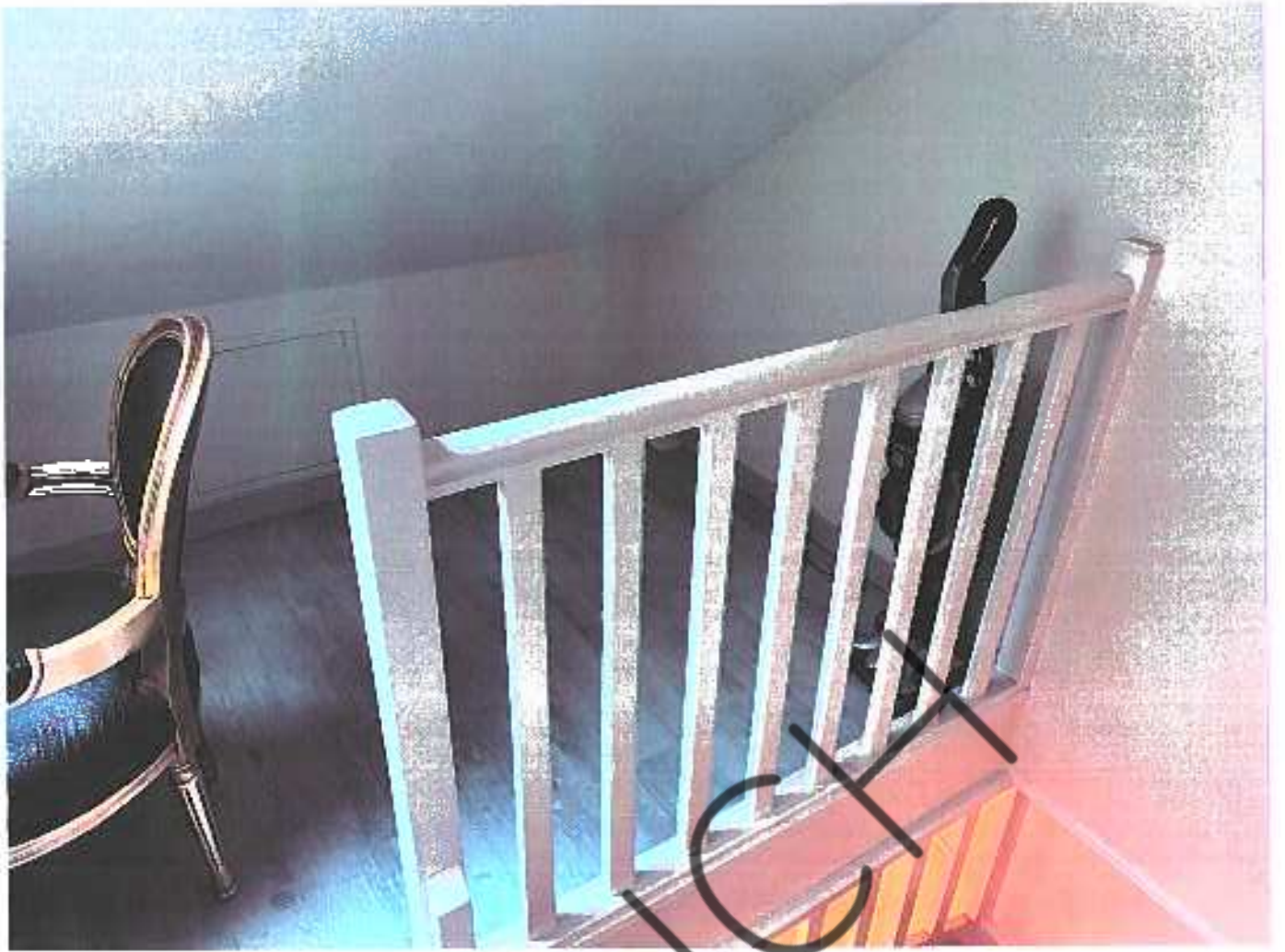
BIC P.V description 48 rue des Bleuets 91600 LONGJumeau 22.12.2021 photo 121
