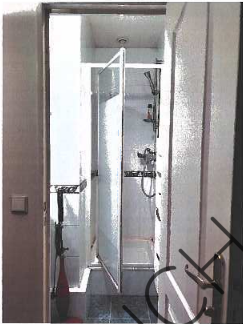
BHC Pw description 48 rue des Brouets 91500 LONGJumeau 22.12.2021 photo 085
