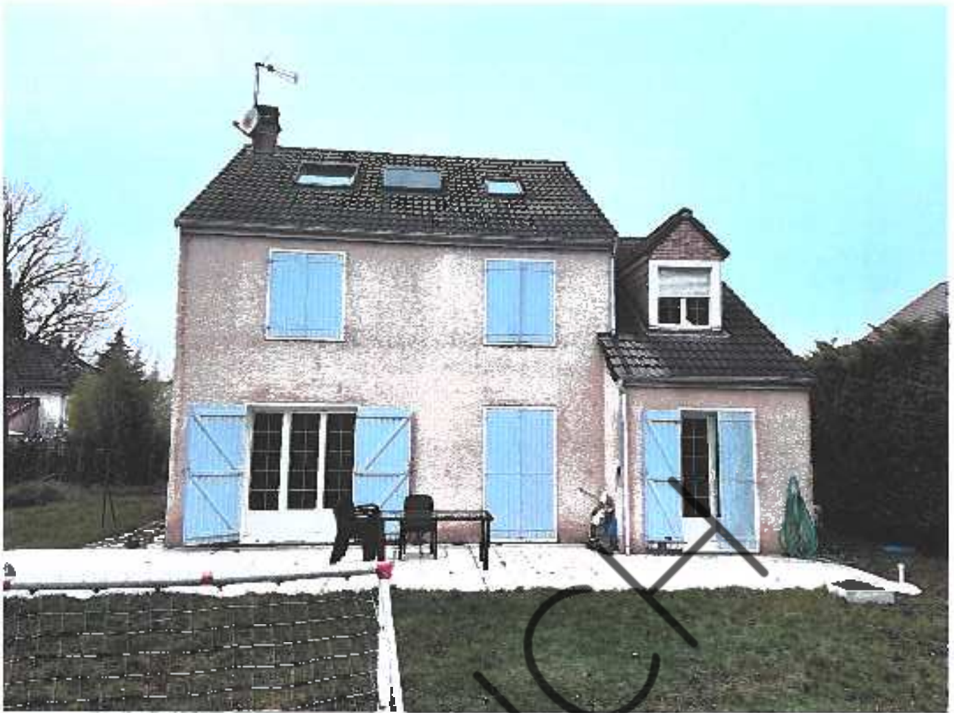
BIC Pr description 45 rue des Bleuets 91501 LONGJumeau 22.12.2021 photo 013
