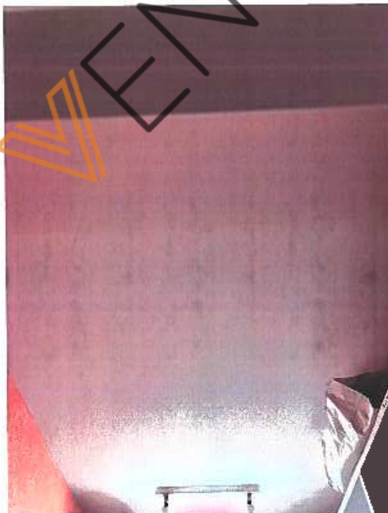
DIC Pr description 46 rue des Bleuets 91500 LONJUMEAU 22.12.2021 photo 100
