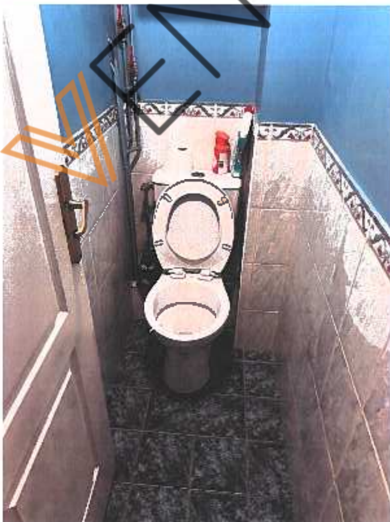
BIC Pr description 45 rue des Bouteils 91501 LONGJumeau 22.12.2021 photo 082
