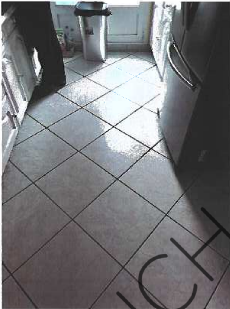
BIC-Pv description 46 rue des Bleuets 9150 LONGJumeau 22.12.2021 photo 037
