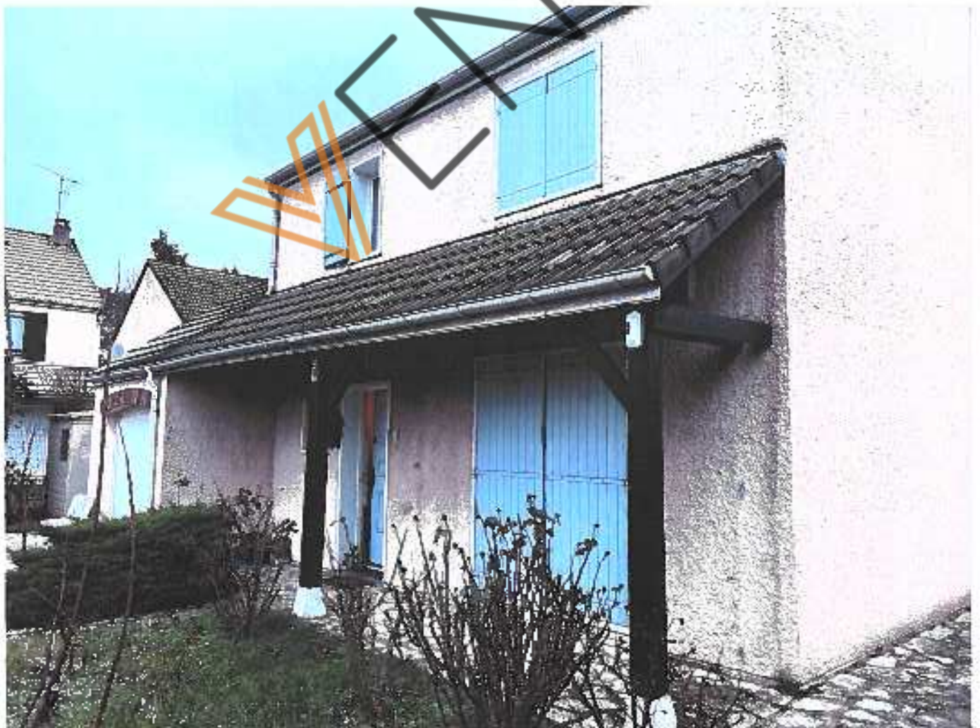
BIC Pv description 48 rue des Bourgs 91500 LONGJumeau 22.12.2021 photo 018
