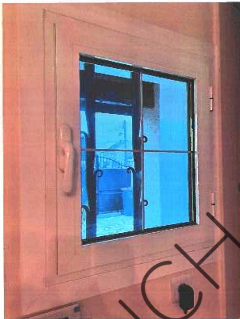
BIG PV description 45 rue des Braves 01600 LONGJumeau 22.12.2021 photo 068
