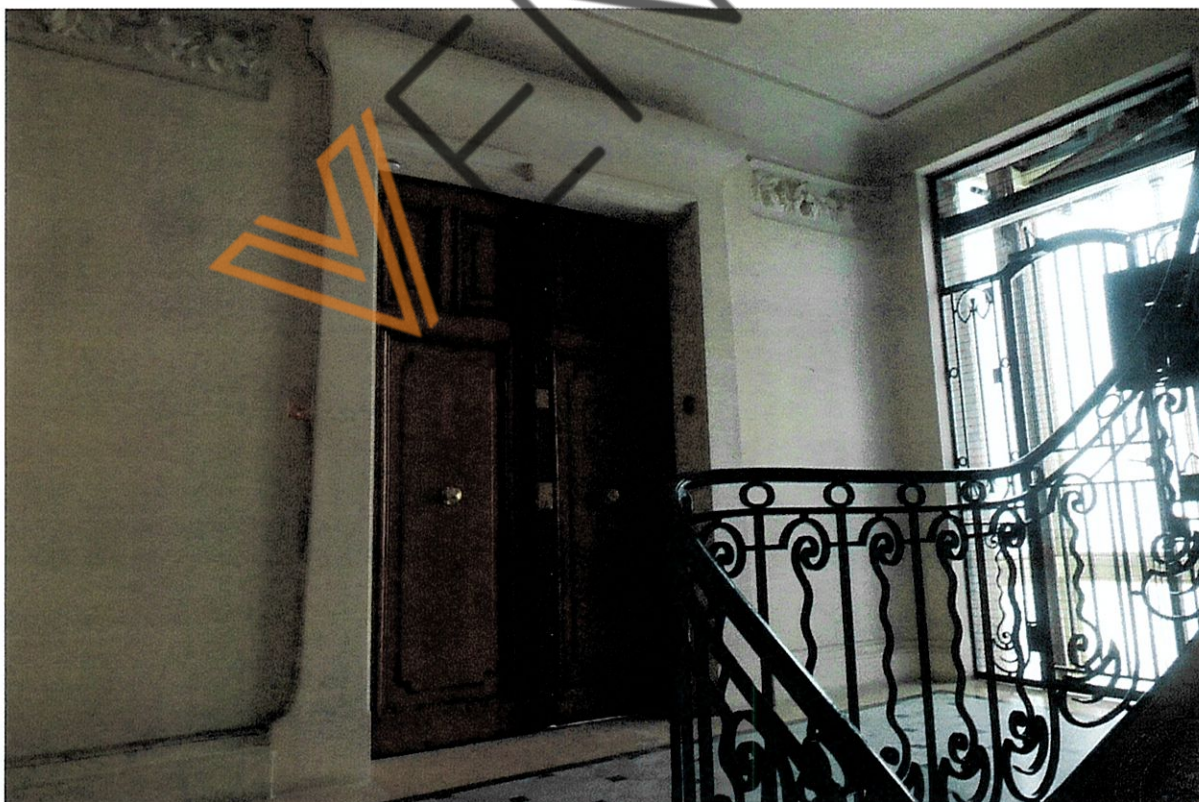
6 Porte de l'appartement au 6 ème étage
