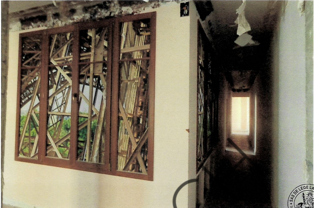
17 Suite et fin du couloir
