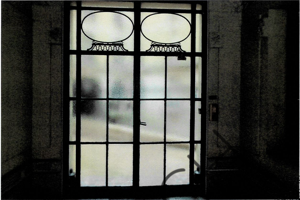
59 Portail vitrée commandant l'accès à la cour et aux parkings
