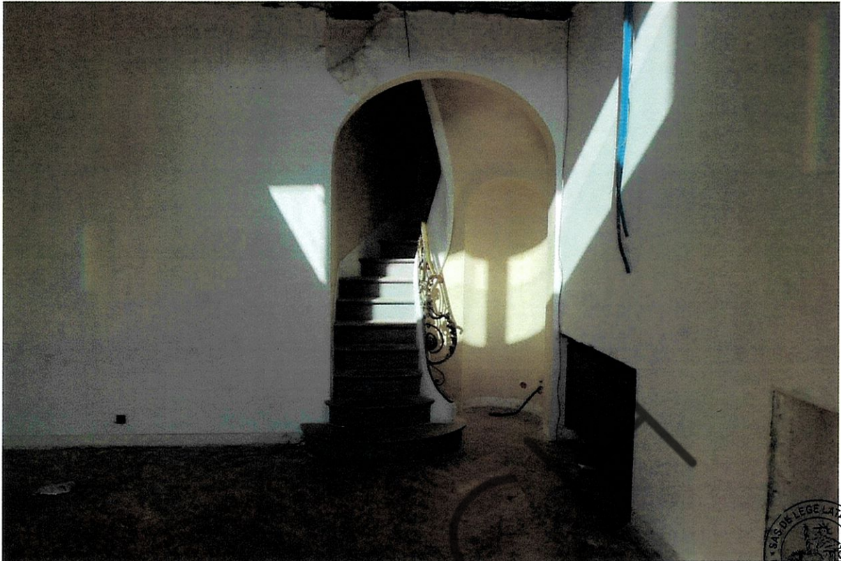
31 Escalier permettant l'accès au niveau supérieur
