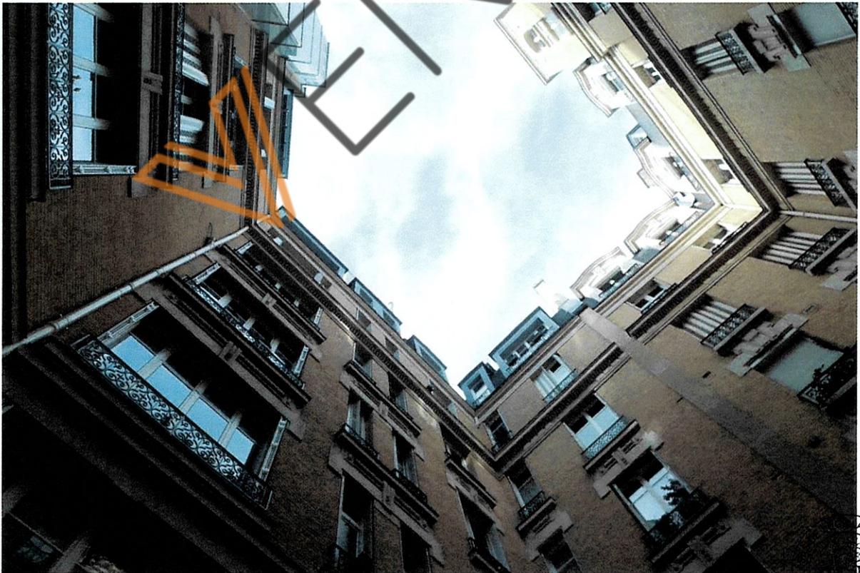
60 Vue de l'immeuble depuis la cour intérieure
