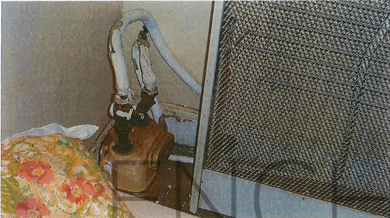
organe de coupure d'appareil d'un appareil alimenté par une tuyauterie fixe est muni d'un about porte-caoutchouc
