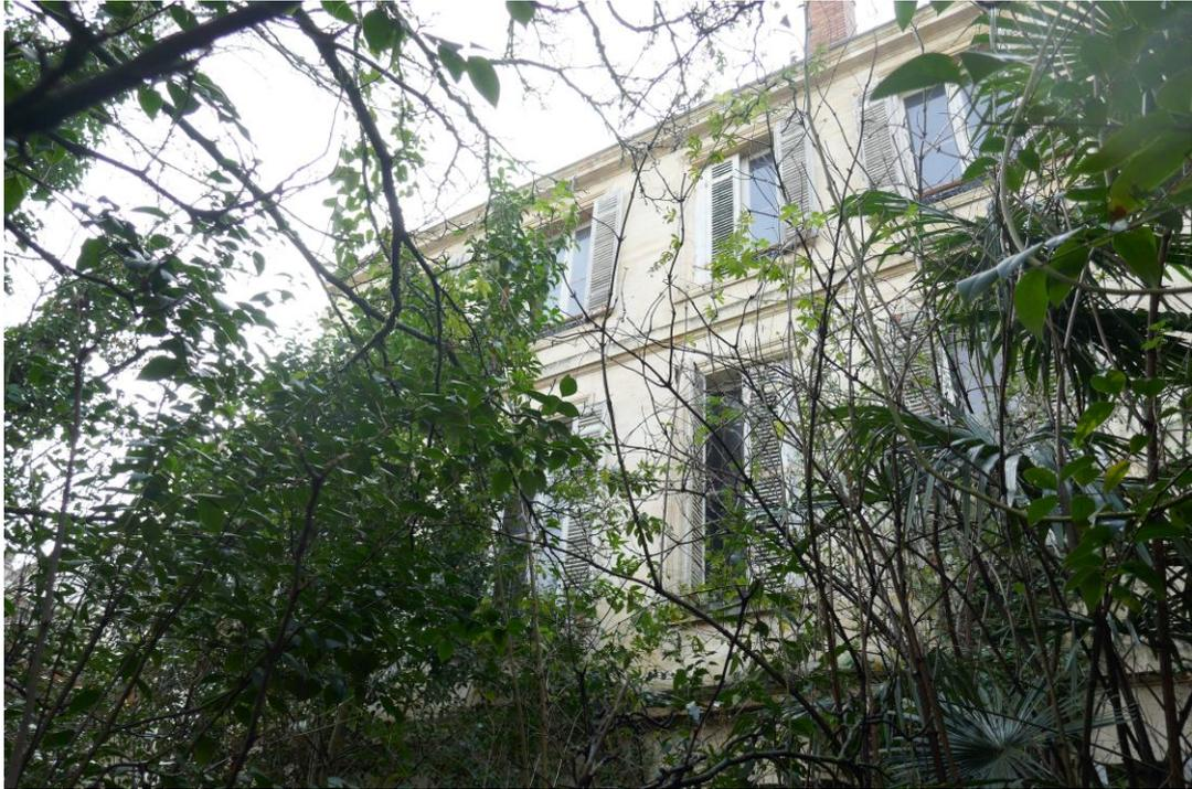
Les volets des fenêtres des deux étages se situent à l'extérieur, contrairement à la façade avant. Les volets sont en bois, en mauvais état.
