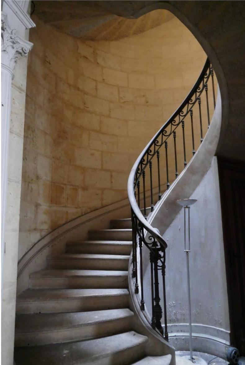
Au niveau du palier permettant d'accéder aux pièces du premier étage, murs en pierres apparentes en bon état général. Quelques traces de coulure au niveau du premier tournant. Le mur est en bon état sur cette portion.
