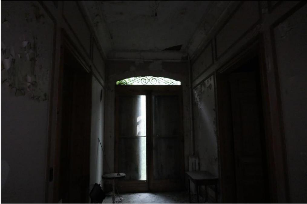
Défauts de planimétrie au niveau du plafond. Différentes couches du plafond sont tombées au sol, notamment du plâtre. Au fond, présence de fissures importantes. Nous apercevons une armature bois au niveau du plafond.
