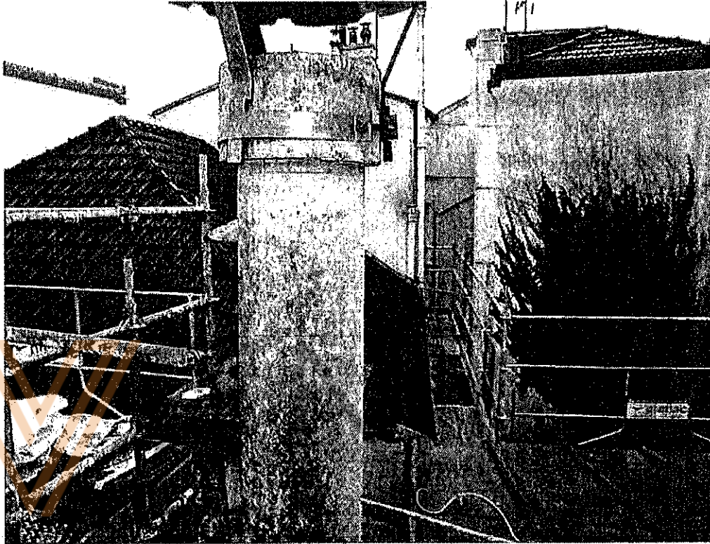
Conduit en amiante ciment n° 6 Bâtiment 23 Toiture
