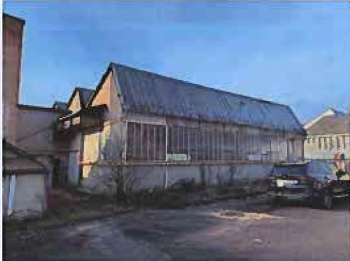
Vue extérieure façade Nord
