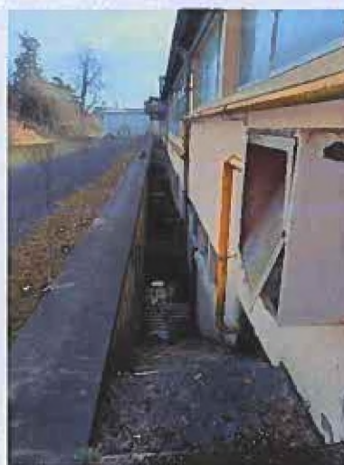
Accès au sous-sol – Façade Nord
