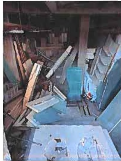
Vue intérieure partie Nord
