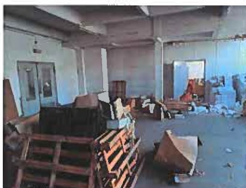
Stockage – Rez de chaussée
