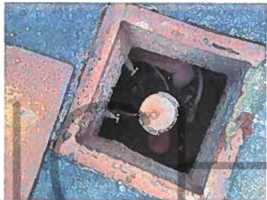
Regard de la cuve enterrée relative au bâtiment 6
