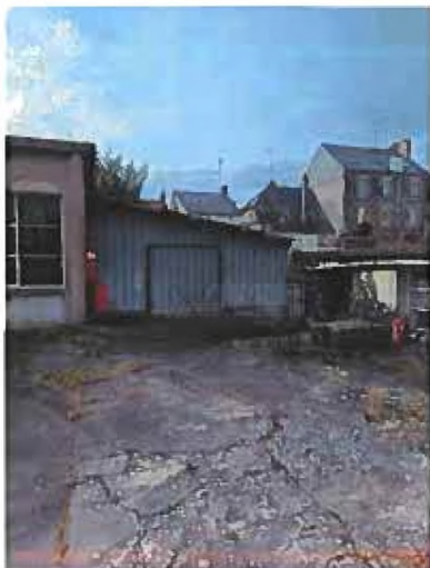
Vue extérieure façade Nord
