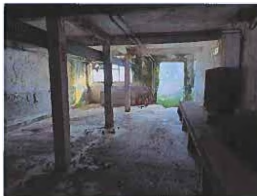
Sous-sol partie Sud
