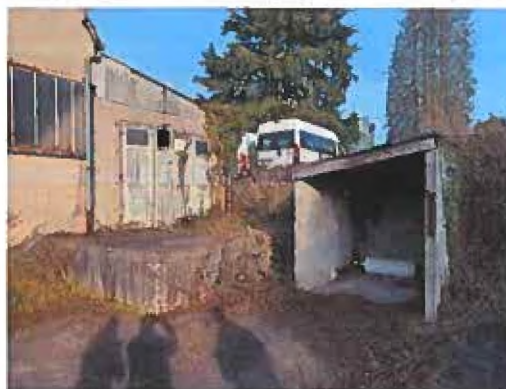
Vue extérieure façade Est et appentis
