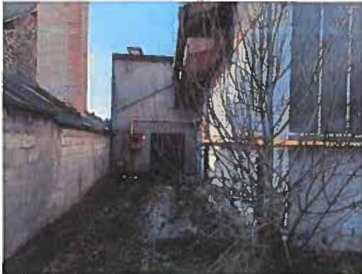
Vue extérieure façade Nord
