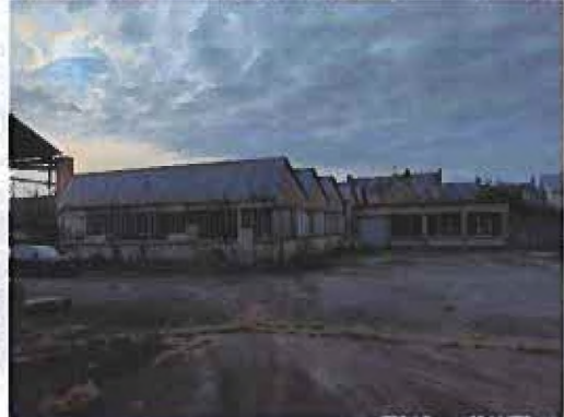
Vue extérieure façades Nord et Ouest
