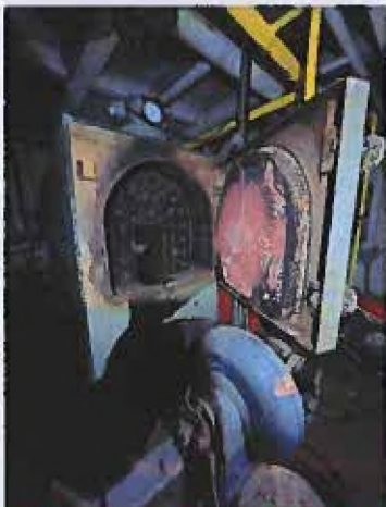
Amiante suspectée sur chaudière - bât. 6 - 8
