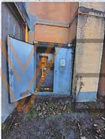
Amiante suspectée sur chaudière - bât. 6 - 8
