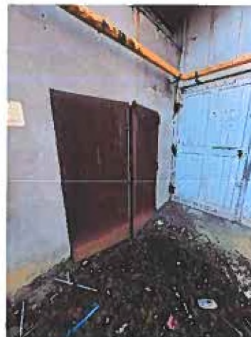
Accès bât. 8, ancienne chaudière ?
