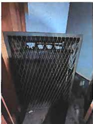
Petit transfo HUILE suspicion PCB - accès contraignant + 4 condensateurs suspectés PCB
