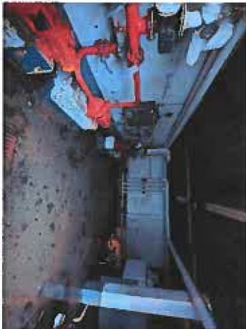
Accès sous-sol Ouest : local pompes de relevage inondé + 2 cuves FOD aériennes
