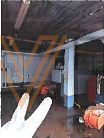
Accès sous-sol Ouest : local pompes de relevage inondé + 2 cuves FOD aériennes
