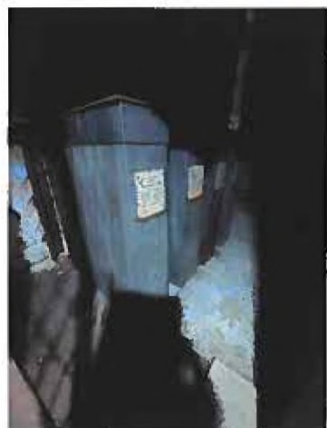
Petit transfo HUILE suspicion PCB - accès contraignant + 4 condensateurs suspectés PCB
