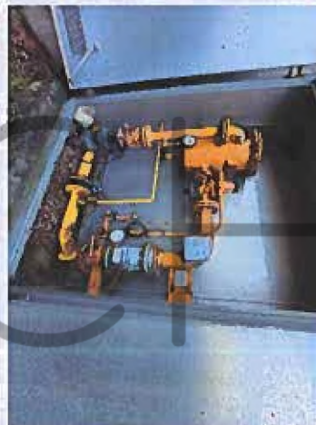
Poste de détente gaz, extrémité Ouest du bâtiment 1 : vannes en position fermée.
