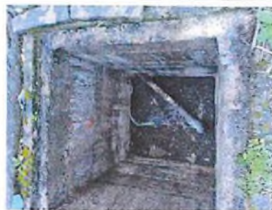
Regard de la cuve enterrée à proximité du bâtiment 2
