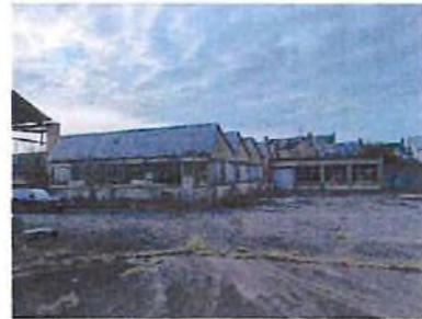
Vue extérieure façades Nord et Ouest
