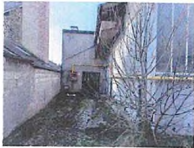
Vue extérieure façade Nord
