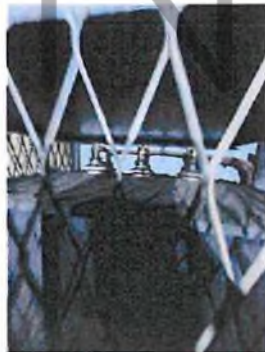
Petit transfo HUILE suspicion PCB - accès contraignant* 4 condensateurs suspects PCB
