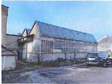
Vue extérieure façade Nord
