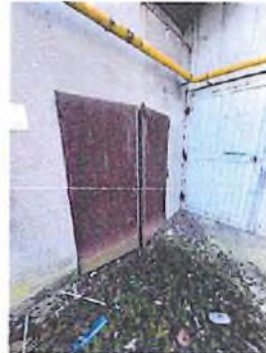
Accès bât. 8, ancienne chaudière ?
