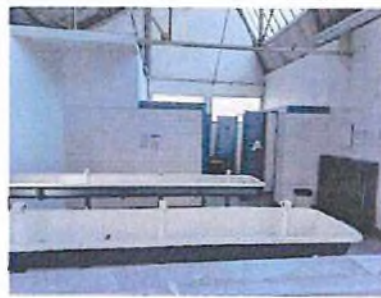
Etage – Ancien vestiaires
