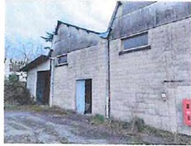
Vue extérieure façade Ouest
