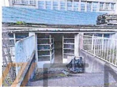
Vue extérieure du sous-sol
