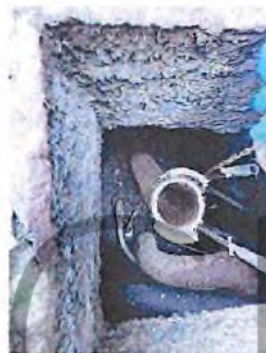
Tube coudé : sondage impossible
