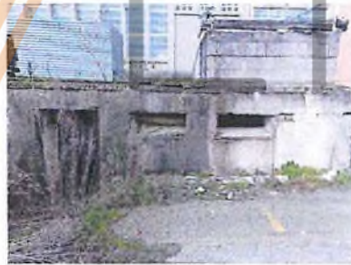
Extérieur - sous-sol et quai de chargement
