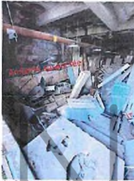
Amiante suspectée sur conduite
