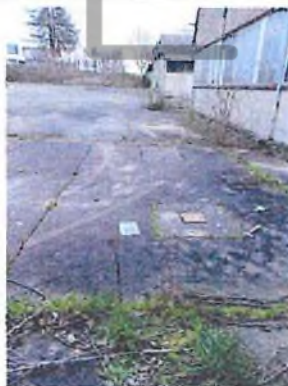
Regard de la cuve enterrée relative au bâtiment 6
