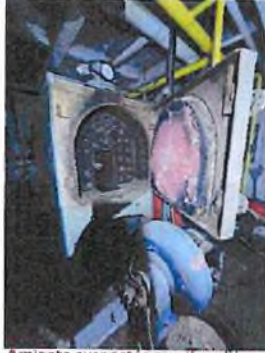
Amiante suspectée sur chaudière - bât. 6 - 8
