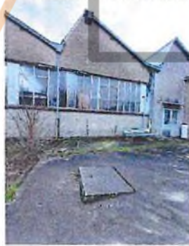
Trappe non ouverte et non repositionnable manuellement
