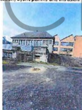
Trou de sondage non rebouché
