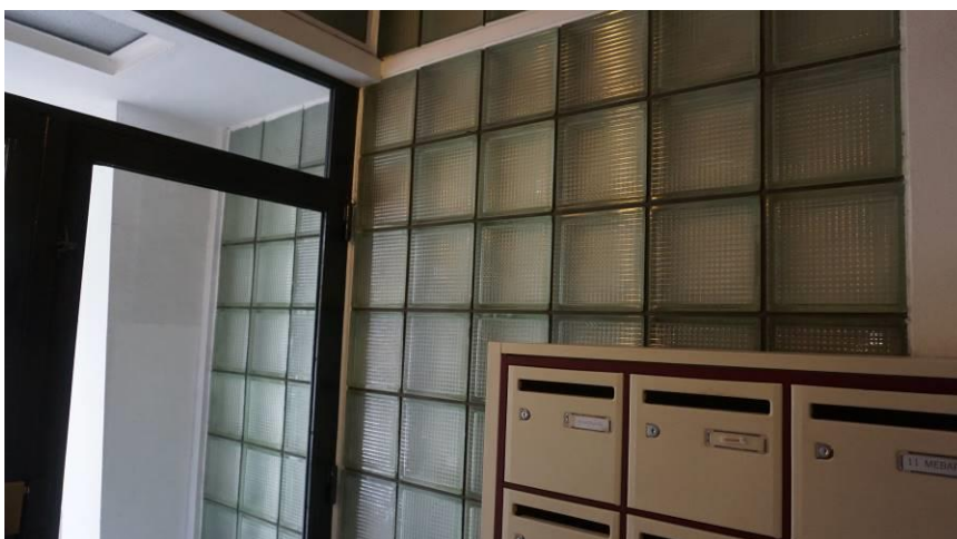
Un ensemble de pavés de verre décoratifs forme jour de souffrance sur la gauche à l'accès.
