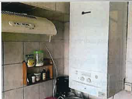
Photo n° PhGaz003 Localisation : Cuisine Chaudière e.l.m. leblanc (Type : Raccordé)
