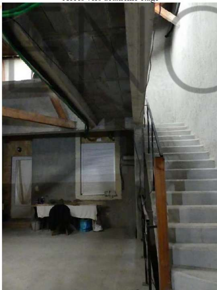
Accès vers deuxième étage
