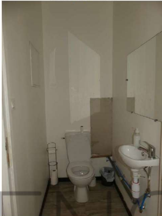
Sanitaire du restaurant
