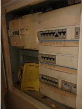
**La présence de disjoncteur différentiel à haute sensibilité 30mA en tête d'installation assure la sécurité des personnes et des biens contre les surintensités et les surtensions.**
