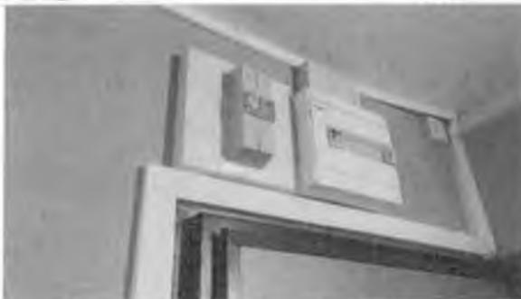
Description : Le dispositif assurant la COUPURE D'URGENCE est placé à plus de 1,80 m du sol fini et n'est pas accessible au moyen de marches ou d'une estrade.
