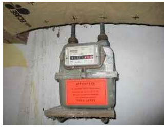
Présence d'un compteur gaz dans la cave
