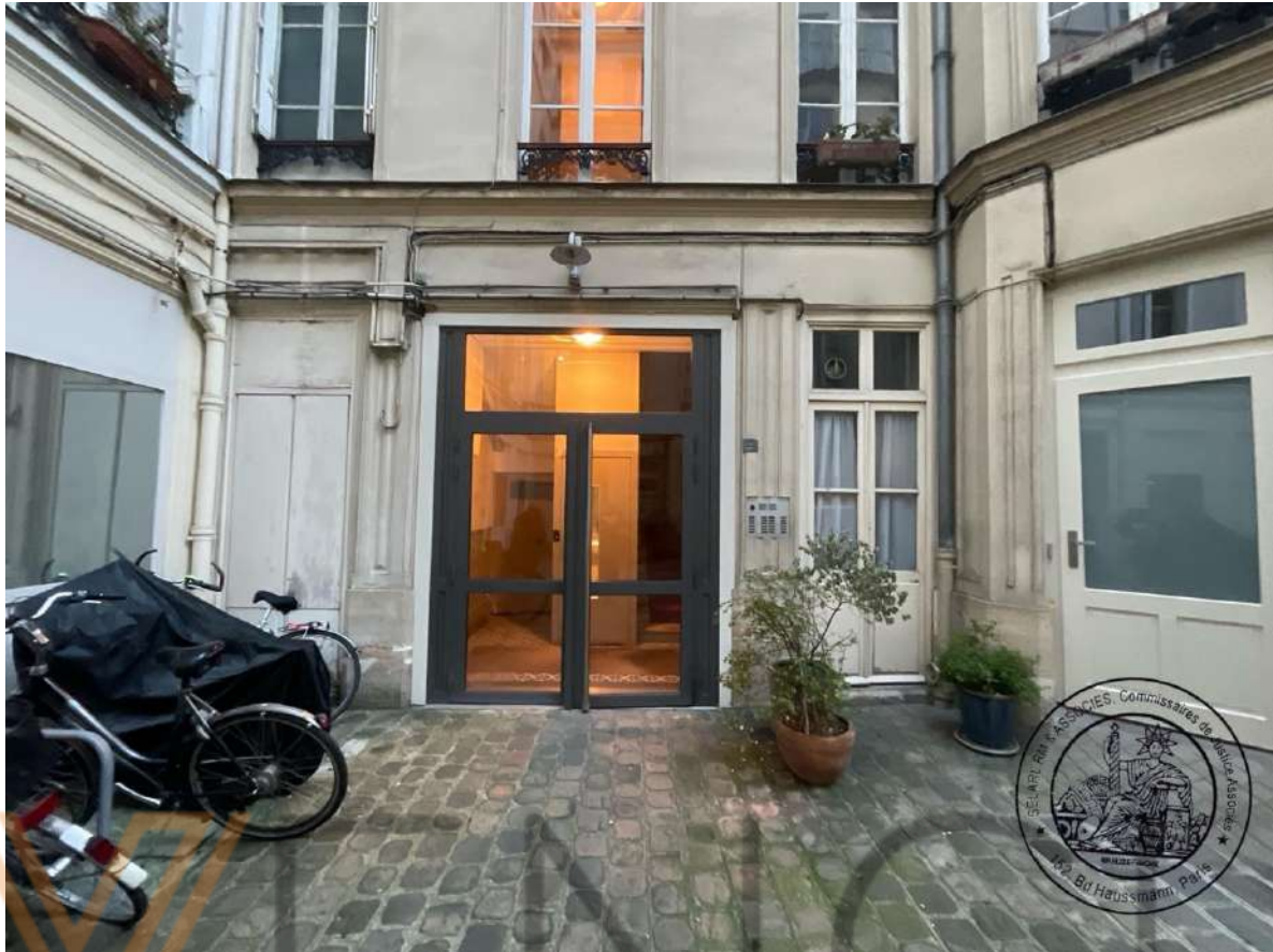
Entrée de l'immeuble
