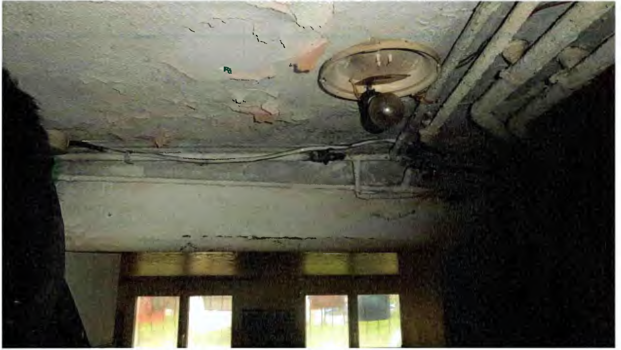
Dégagement – fuite provenant du plancher haut
