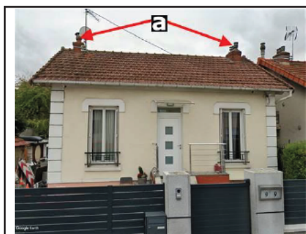
Photo n° PhA001 Localisation : Parties extérieures Ouvrage : 1 - Couvertures, Toitures, Terrasses et étanchéités - Éléments associés à la toiture Partie d'ouvrage : Conduit de cheminée Description : Chapeau de cheminée en fibro-ciment
