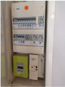
**Aucune anomalie au jour de la visite.****La présence de disjoncteur différentiel à haute sensibilité 30mA en tête d'installation assure la sécurité des personnes et des biens contre les surintensités et les surtensions.**
