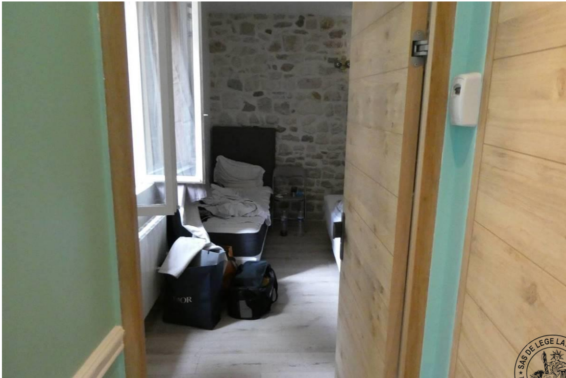
13 Rez-de-chaussée partie gauche
