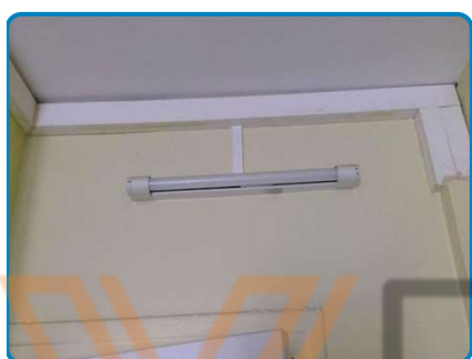
Anomalie B.3.3.6 a3 sur Install. n°1
