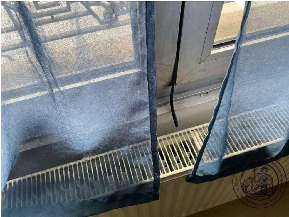
Joint abimée au niveau de la fenêtre de gauche
