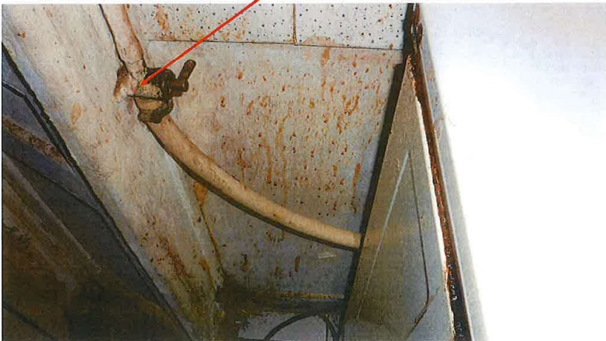
organe de coupure d'appareil d'un appareil alimenté par une tuyauterie fixe est muni d'un about porte-caoutchouc
