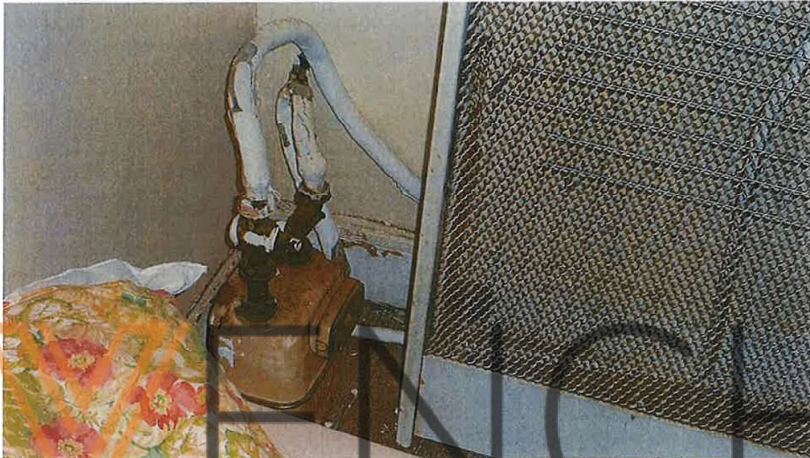
organe de coupure d'appareil d'un appareil alimenté par une tuyauterie fixe est muni d'un about porte-caoutchouc
