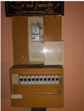
La pose d'un disjoncteur différentiel à haute sensibilité 30mA en tête d'installation lèvera certaines anomalies, et surtout assurera la sécurité des personnes et des biens contre les surintensités et les surtensions.
