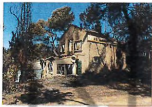
Maison non débroussaillée partiellement détruite par le passage d'un feu de forêt (12) source : GDF
