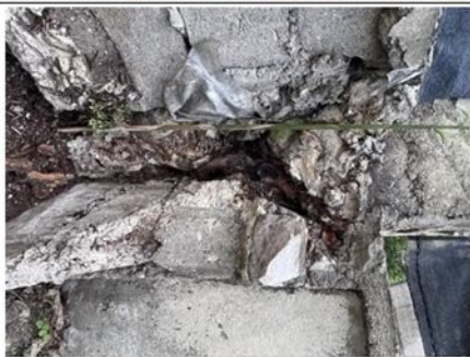
Photo n° PhTer001 Localisation : Parties extérieures Ouvrage : Débris de végétaux Parasite : Présence d'indices d'infestation d'autres agents de dégradation biologique du bois, Type non spécifié Indices : dégradation du bois, présence de vermoulure (dégradation(s) importante(s), présence étendue)
