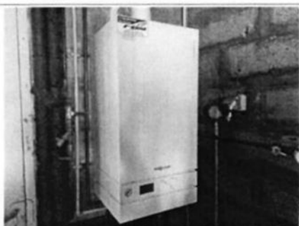
Photo n° PhGaz001 Localisation : Maison - Garage Chaudière Viessmann (Type : Etanche)
