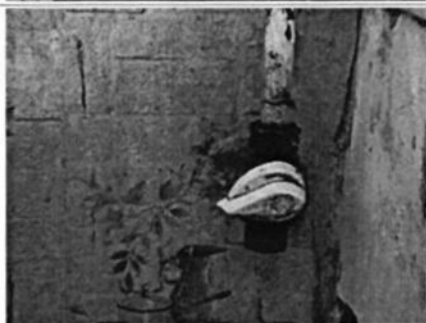
Photo n° PhGaz002 Localisation : Maison - Cuisine Robinet en attente Sans objet (Type : Non raccordé)
