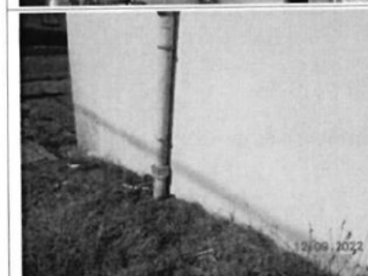
Photo n° PhA027 Localisation : Parties extérieures Ouvrage : 6 - Conduits et accessoires intérieurs - Conduits de fluides (air, eau, vapeur, fumée, échappement, autres fluides) Partie d'ouvrage : Conduit en fibres-ciment Description : Conduit en fibres-ciment Localisation sur croquis : M027
