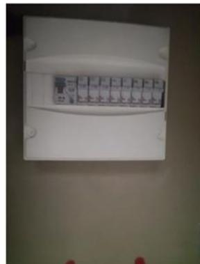
**La présence de disjoncteur différentiel à haute sensibilité 30mA en tête d'installation assure la sécurité des personnes et des biens contre les surintensités et les surtensions.**
