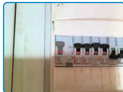
PROTEC.DIFF. sur Install. n°1 (dans Appartement 3ème étage Entrée + rangement)
