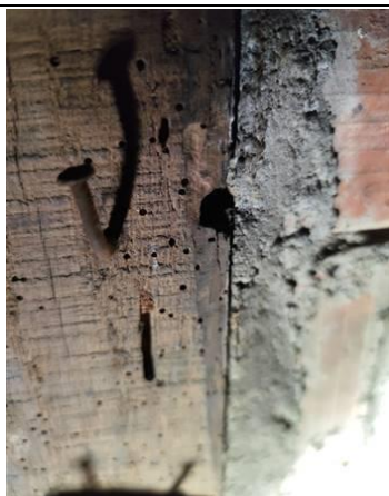
Photo n° PhTer001 Localisation : Sous-sol - Cave Ouvrage : Porte - Bois Parasite : Anobium punctatum (Petites vrillettes) Indices : présence de trous de sortie (présence faible)
